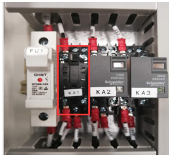
图 13 中间继电器插入底座前实物图
