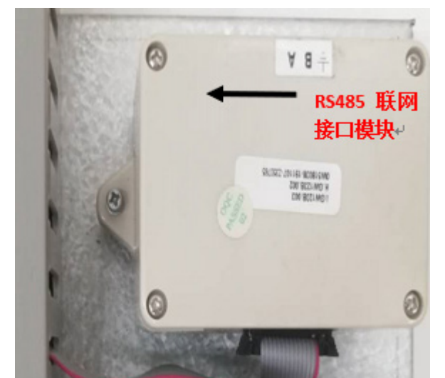
图12 RS485 联网接口模块安装后实物图
