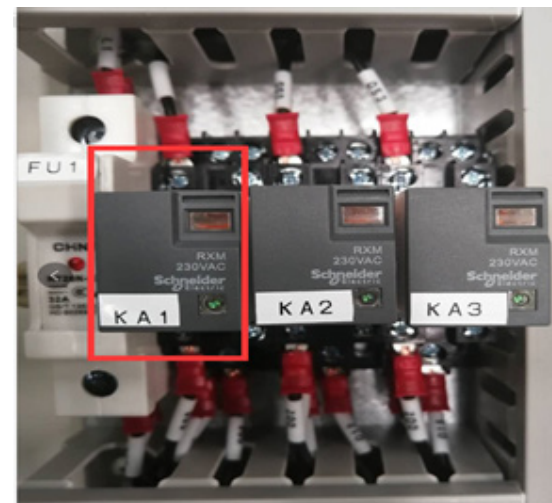
图 14 中间继电器插入底座后的实物图
