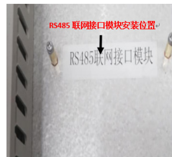
图 11 RS485 联网接口模块安装位置图
