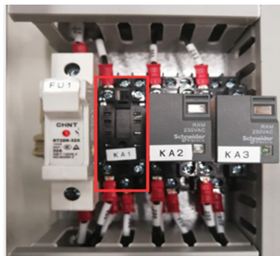
图 13 中间继电器插入底座前实物图
