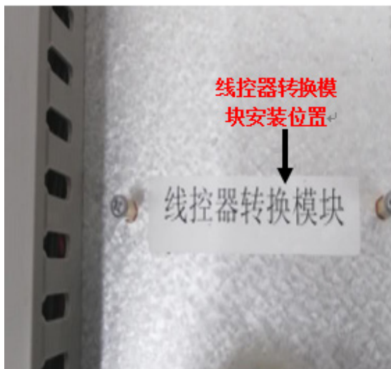
图 4 线控器转换模块安装位置图
