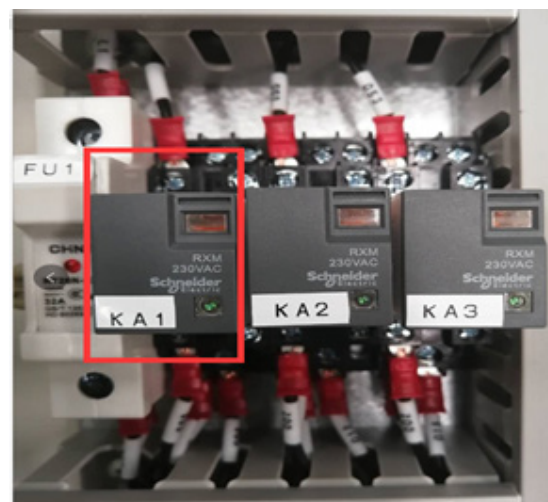
图 14 中间继电器插入底座后的实物图
